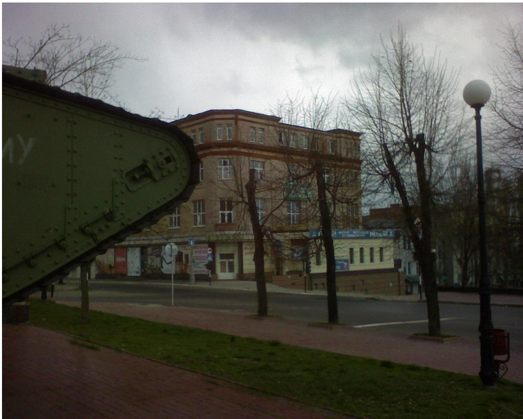
Фото 4. Вид на здание со стороны танка
