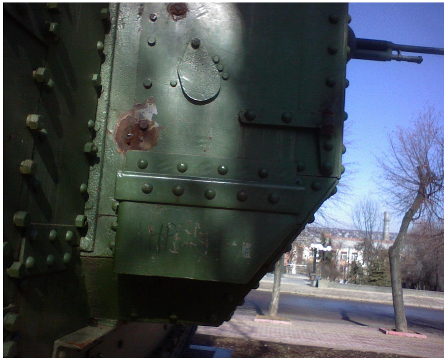
Фото 64. заваренная дверь в консоне
