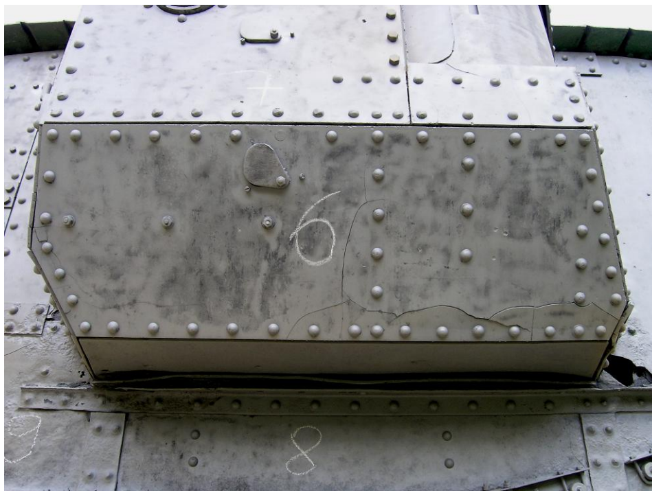
Фото 28. Вмятины от пуль на броневых плитах справа и много трещин Трещина выше вентиляционной решетки. Фото 29, 30.
