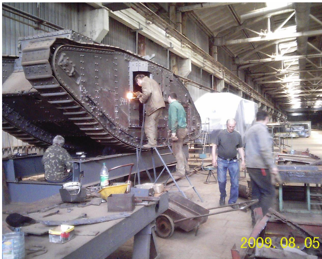
Фото 43. Подварка корпуса танка
