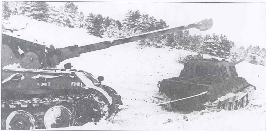
Фотография иллюстрирует процесс транспортировки «Ягдтигром» танка «Тигр II». Буксировка ведется по бездорожью, что опровергает мнение некоторых исследователей, считающих, что «Ягдтигр» с трудом мог передвигаться сам (и то лишь по хорошей дороге), но не тянуть себе подобных.
