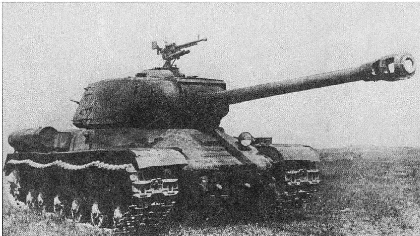
**Испытания зенитной турели ДШК на танке ИС. 1945 г.**
