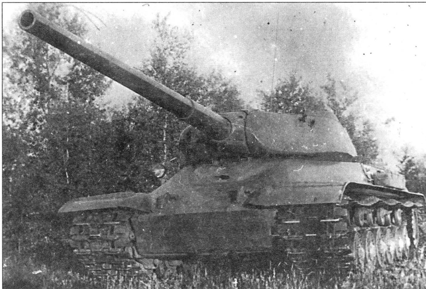
Тяжелый танк «Объект 701-2» – прототип танка ИС-4, выпуска 1944 г.
