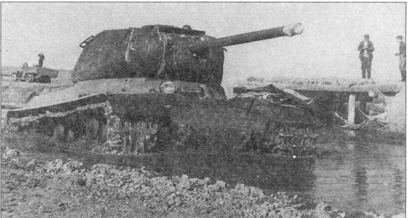
**Опытный танк ИС, вооруженный 85-мм орудием С-31, во время Государственных испытаний.**
