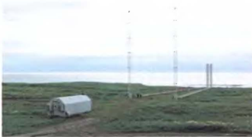
Рис. 4 Передающая антенна ЗГ РЛС поверхностной волны
