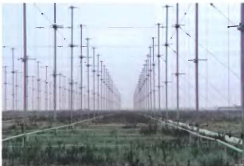
Рис. 5 Приемная антенна ЗГ РЛС поверхностной волны
