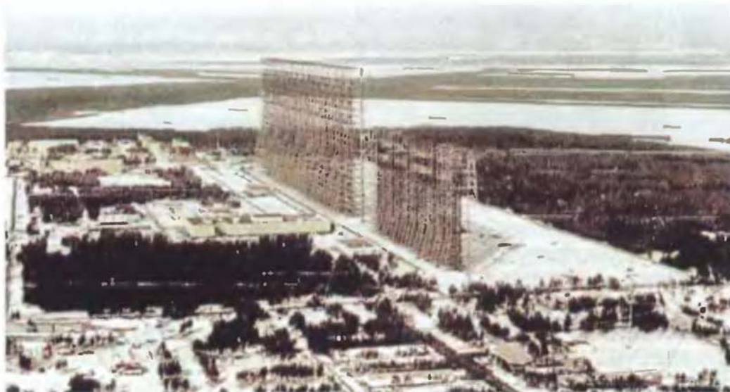
Рис. 2 Антенная система ЗГ РЛС. Узел № 2
