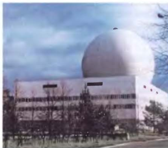
Рис. 5 Пункт управления комплекса ИС
