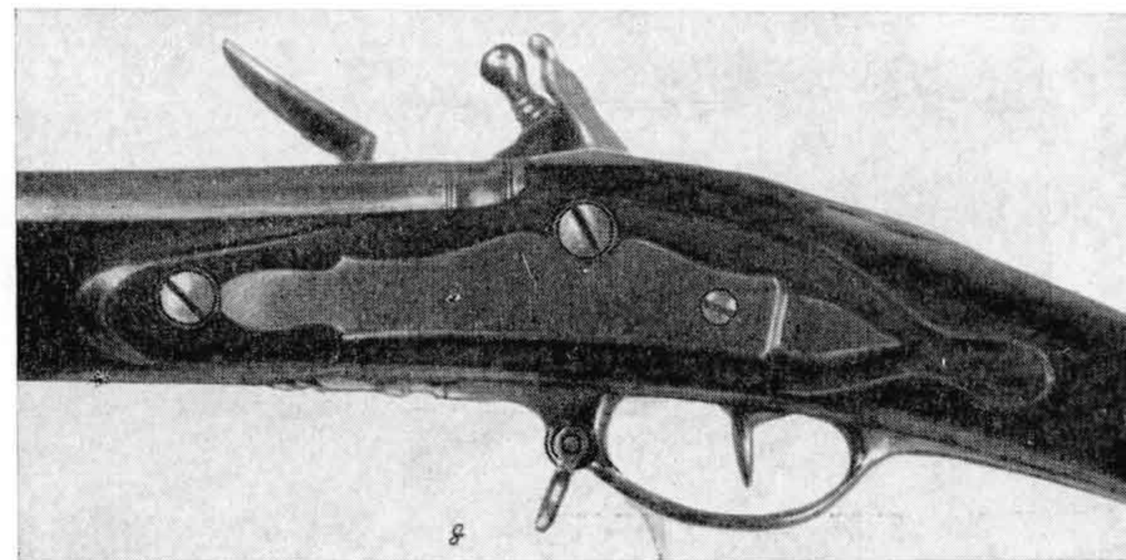
Рис. 73. Солдатское ружье лейб-гвардии Семеновского полка 1788 г. Эталон (ВИМАИВ и ВС, инв. № 1/139): a — общий вид; b — надпись на стволе; c — спусковая скоба; d — затыльник приклада; e — накладка под замочные винты
