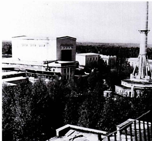
Здание, где размещался промышленный реактор «А» (комбинат «Маяк», г. Озерск)
