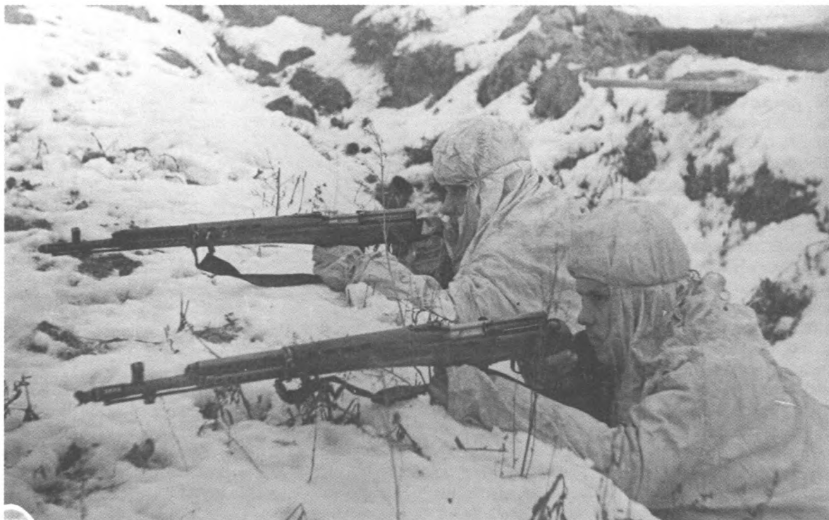
Снайтеры В.Королев (впереди) и А. Строчаченко ведут наблюдение за противником. Декабрь 1941 года. Ленфронт. Из фондов ЦГАКФД СПб. Редкий снимок. В дульный тормоз винтовки на переднем плане вставлена тряпичная пробка, что создает предпосылки к его разрыву при выстреле
