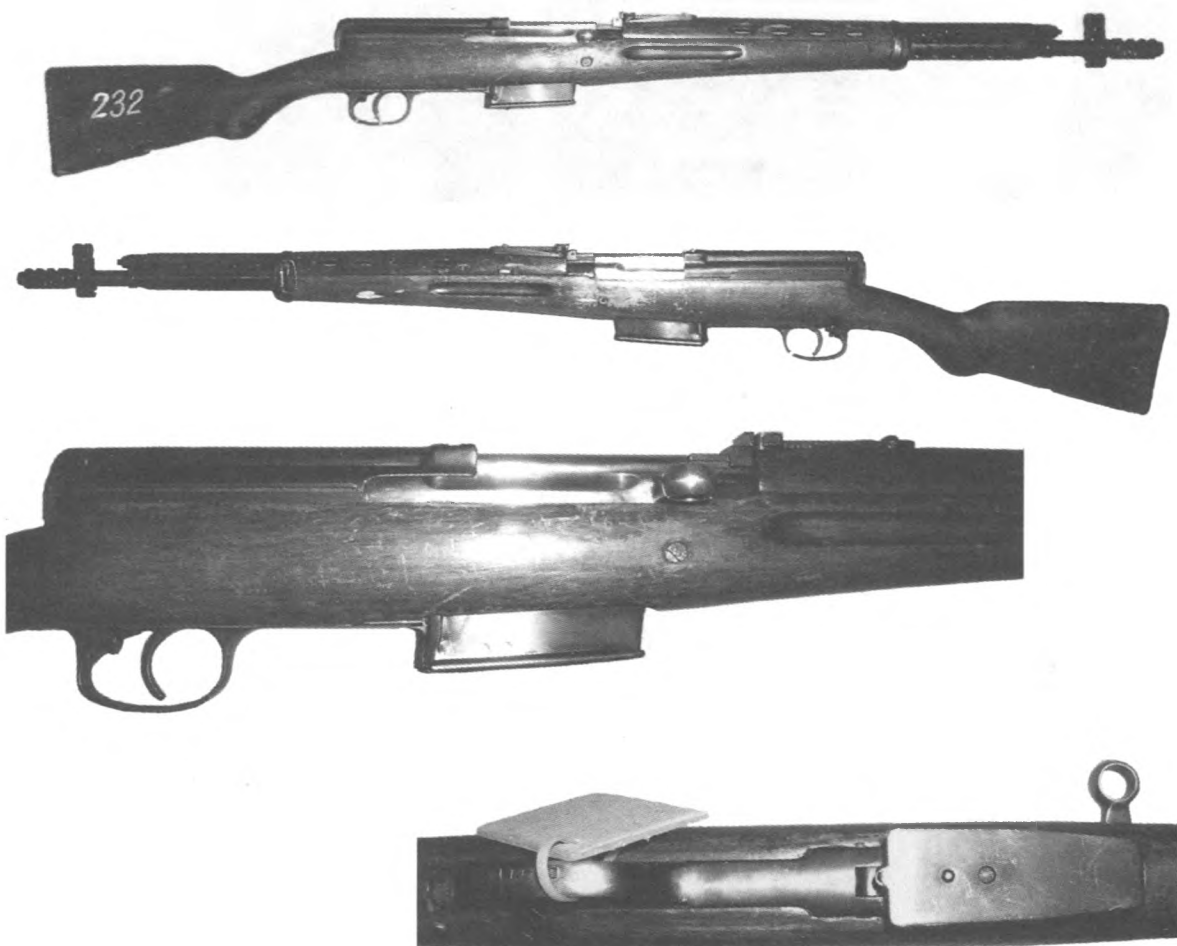
Самозарядная винтовка 1942 г. с постоянным магазином на 5 патронов (ИЖГТУ)
