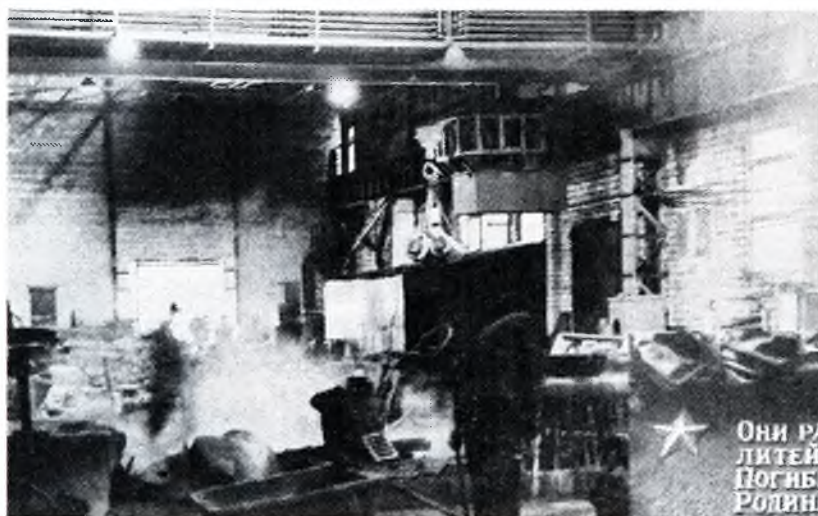
ФАСОННО-ЛИТЕЙНЫЙ ЦЕХ АМЗ. ФОТО ВТОРОЙ ПОЛОВИНЫ XX ВЕКА.
