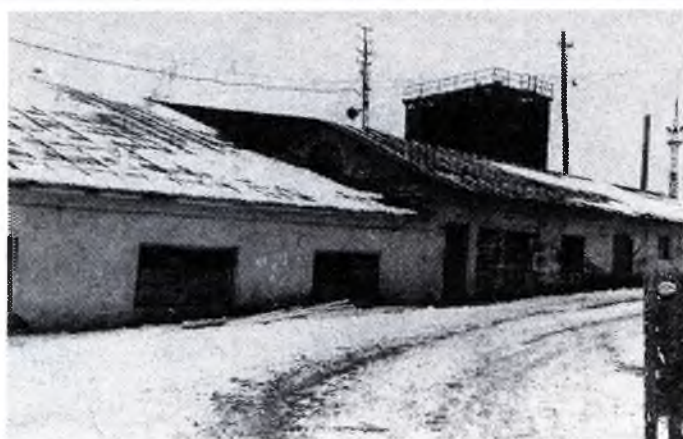
ЦЕХ РЕМОНТА МЕТАЛЛУРГИЧЕСКИХ ПЕЧЕЙ АМЗ. ФОТО ПОСЛЕДНЕЙ ЧЕТВЕРТИ XX ВЕКА
