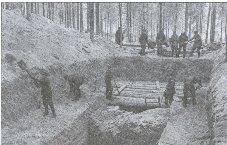
Финские резервисты строят дерево-земляное укрытие для личного состава в районе деревни Кирвесмяки. Декабрь 1939 года. «Talvisodan historia» (том II)
