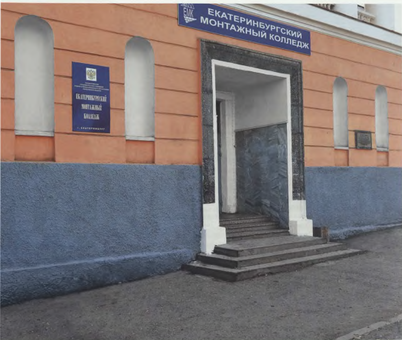
Екатеринбургский монтажный колледж. Улица Декабристов, 83.
