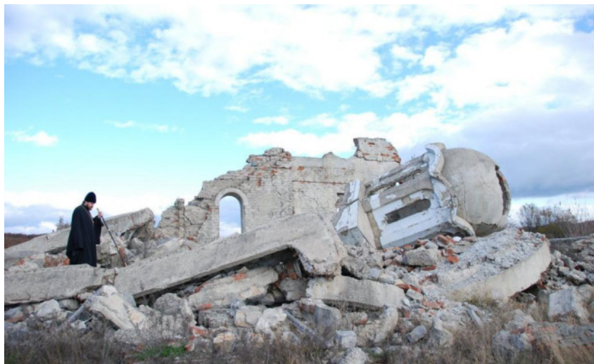
ФОТО 37. Разрушенный храм Сербской православной церкви
