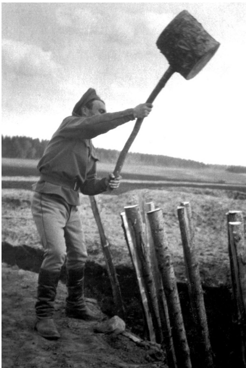
Забивание кольев при обшивке стен окопа
