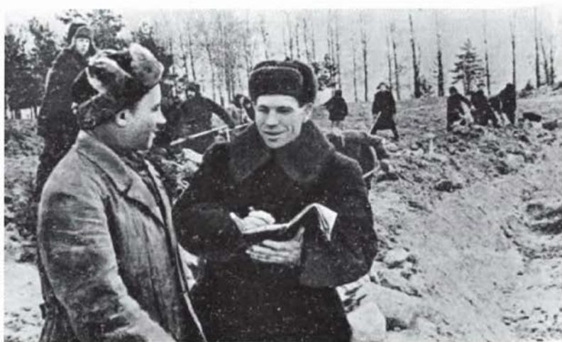
Строительство оборонительных сооружений под г.Ростовом Ярославской области. Бригадир одной из лучших строительных бригад Ф.В.Гусев (слева) и комиссар А.А.Черноусов, 1941 г.
