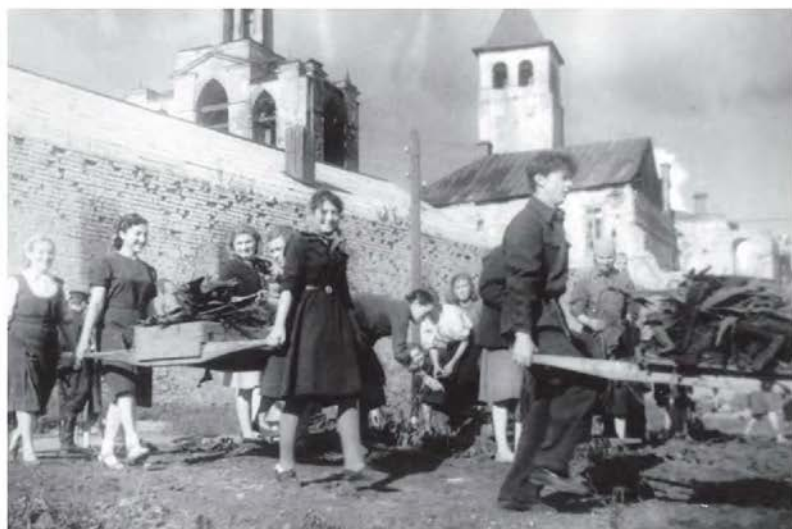
Во время работ по благоустройству Которосльской набережной в г.Ярославле, 1944 г.
