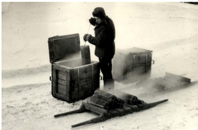
Рис. 8. Выемка насыщенных кислородом оксипатронов. 1944 г.
