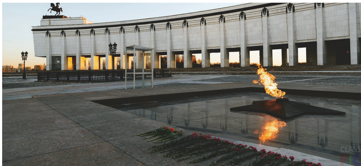
Музей Победы на Поклонной горе в Москве - место проведения Международного форума, посвященного 75-летию Нюрнбергского трибунала. 2020 г.
