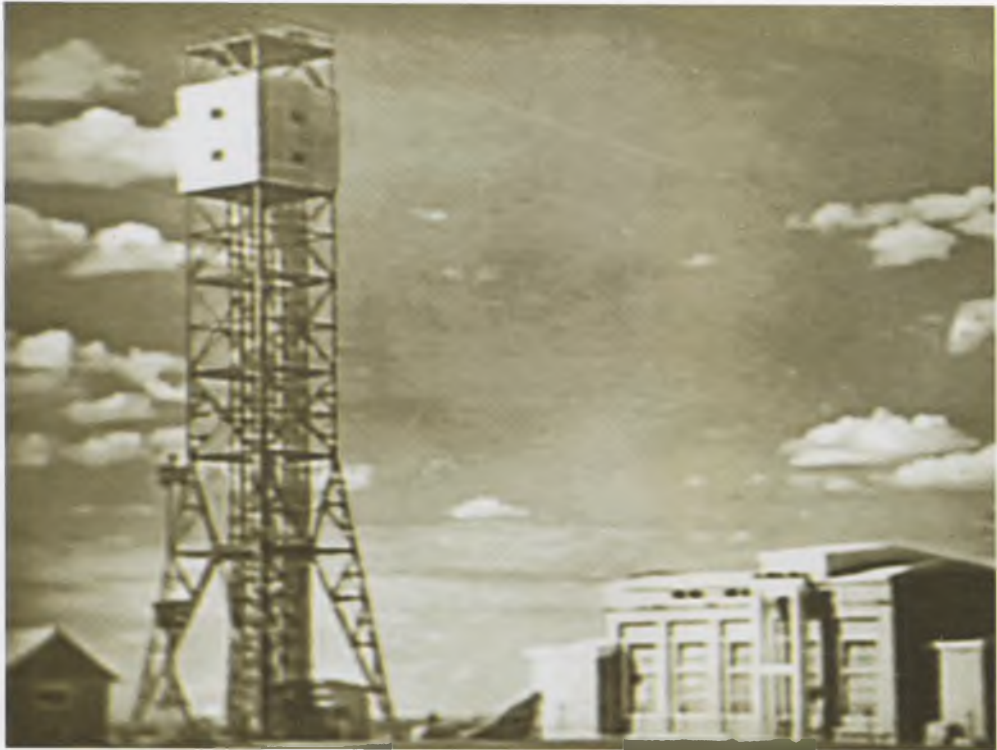
Испытательная башня на Семипалатинском полигоне. Август 1949 г.
