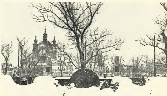
Батарея у Смольного.
