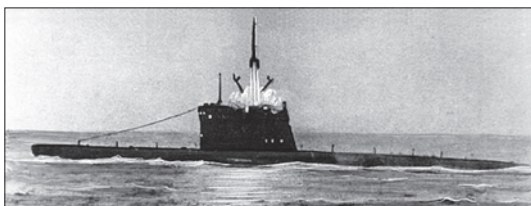
Ракета Р-11ФМ стартует с подводной лодки проекта АВ611
