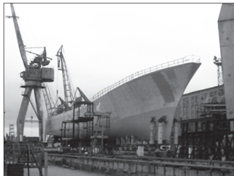
Корпус строящегося сторожевого корабля «Новик» пр. 11441 на стапеле ССЗ «Янтарь», г. Калининград. 10 октября 2003 г.
