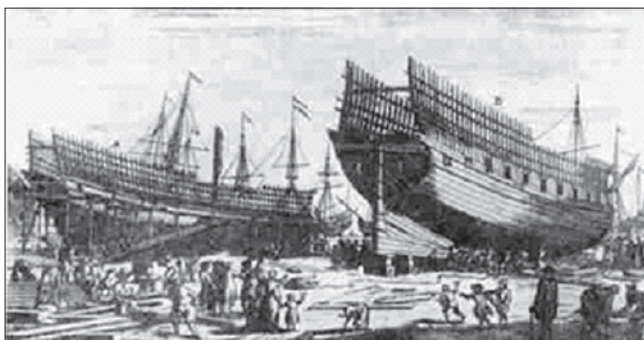
Боевые корабли с вырезанными пушечными портами, строящиеся на голландской верфи в начале XVIII века
