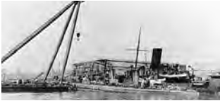
РЕМОНТНЫЕ МАСТЕРСКИЕ В ПОРТ-АРТУРЕ. ЗАМЕНА ВИНТОВ НА МИНОНОСЦЕ «ЛЕЙТЕНАНТ БУРАКОВ». 1904 Г.
