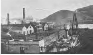
ПОРТ-АРТУР. ДОКОВЫЙ РЕМОНТ КАНОНЕРСКОЙ ЛОДКИ «ОТВАЖНЫЙ»
