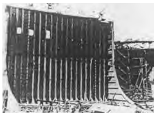
КЕССОН ДЛЯ РЕМОНТА КРЕЙСЕРА «ПЕТРОПАВЛОВСК». 1941–1942 ГОДЫ.
