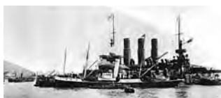
ЗАВОДКА КЕССОНА ПОД БРОНЕНОСЕЦ «РЕТВИЗАН»
