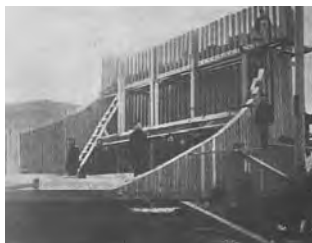
КЕССОН ДЛЯ РЕМОНТА КОРМОВОЙ ЧАСТИ БРОНЕНОСЦА «ЦЕСАРЕВИЧ»
