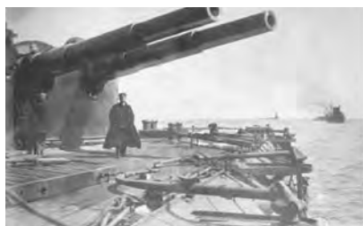
КОРМОВАЯ 305 ММ ДВУХОРУДИЙНАЯ БАШНЯ БРОНЕНОСЦА «ПЕТРОПАВЛОВСК»
