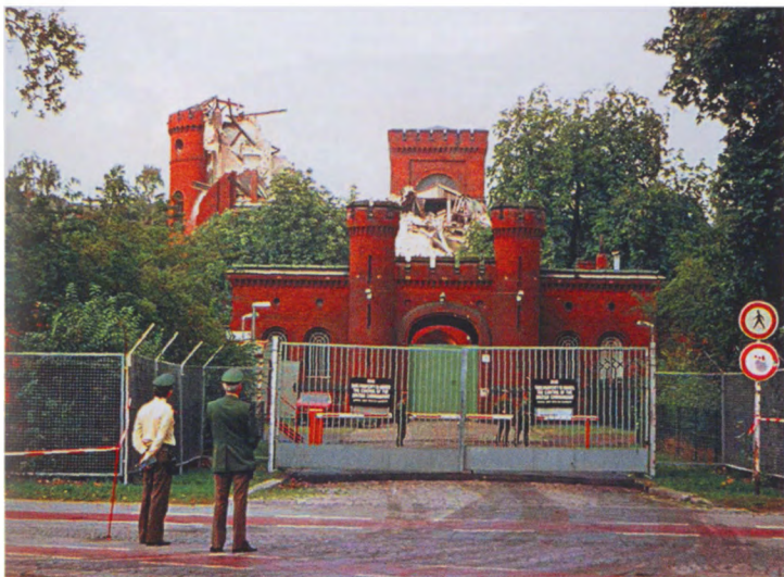
Начало разрушения тюрьмы Шпандау. Сентябрь 1987 года
