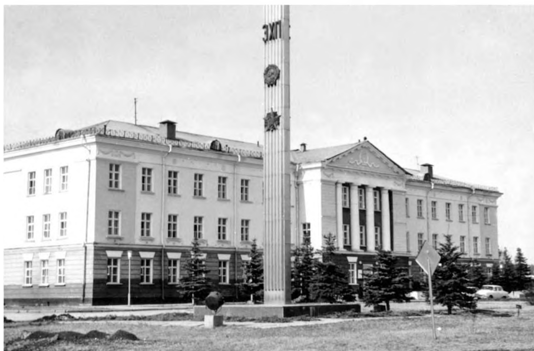
Здание управления завода — комбината «ЭХП»
