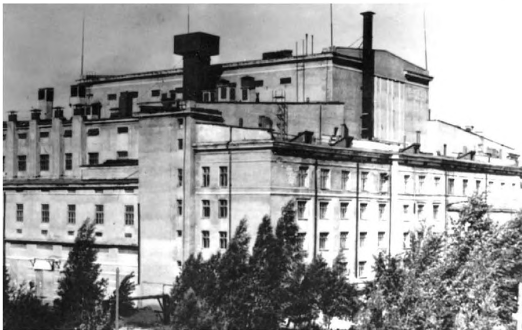
Здание Первого цеха
