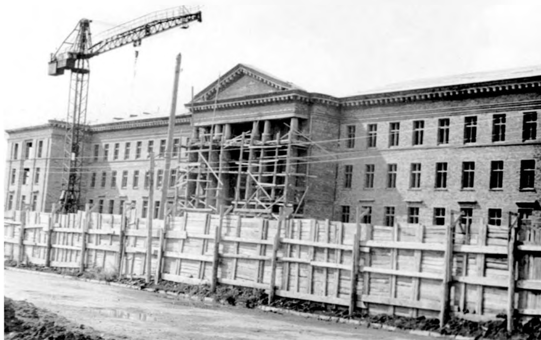
Строительство здания МИФИ-3. 1958 г. (из архива В.А. Терёшина)
