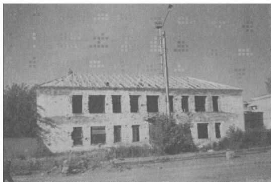
Разрушенная школа в селе Старые Атаги
