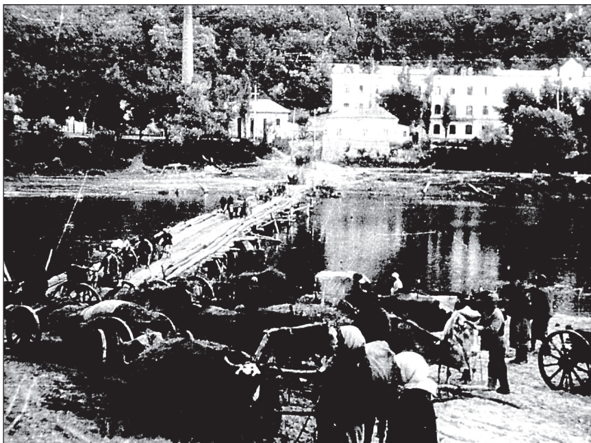
Разрушенный архитектурный комплекс монастыря после освобождения Святогорска
