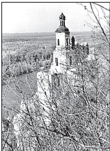
Состояние Николаевской церкви после войны
