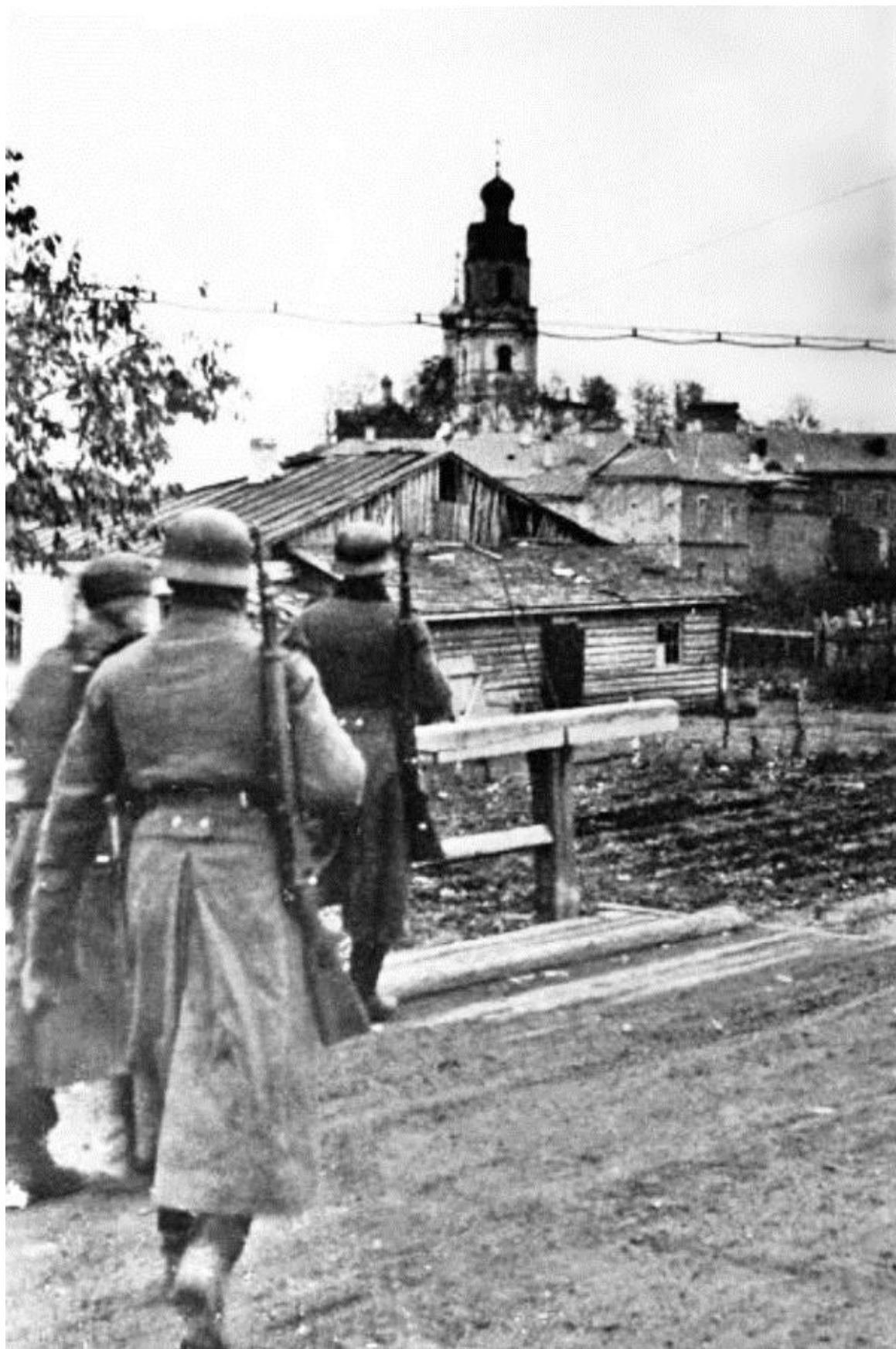
Немецкие войска входят в Вязьму. Кировский мост через реку Вязьма, октябрь 1941 г
