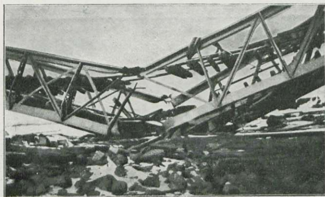
Желѣзнодорожный мостъ, разрушенный при отступленіи отъ Мукдена.
