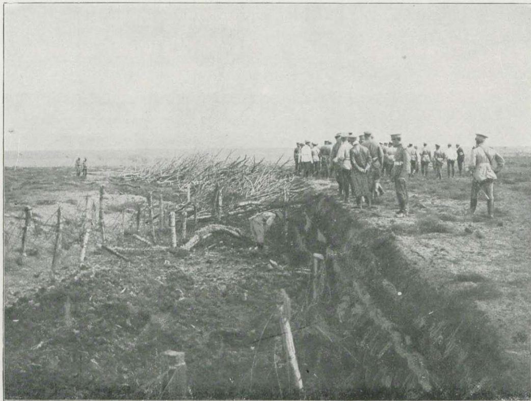
Передовыя позиціи съ засѣками и проволочными загражденіями, отчасти разрушенными взрывами.
