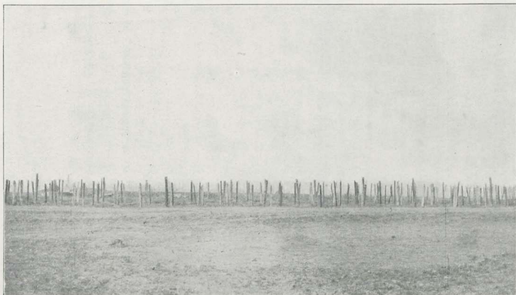
Проволочныя загражденія съ волчьими ямами вокругъ форта № 1 на главныхъ позиціяхъ 1-ой арміи.
