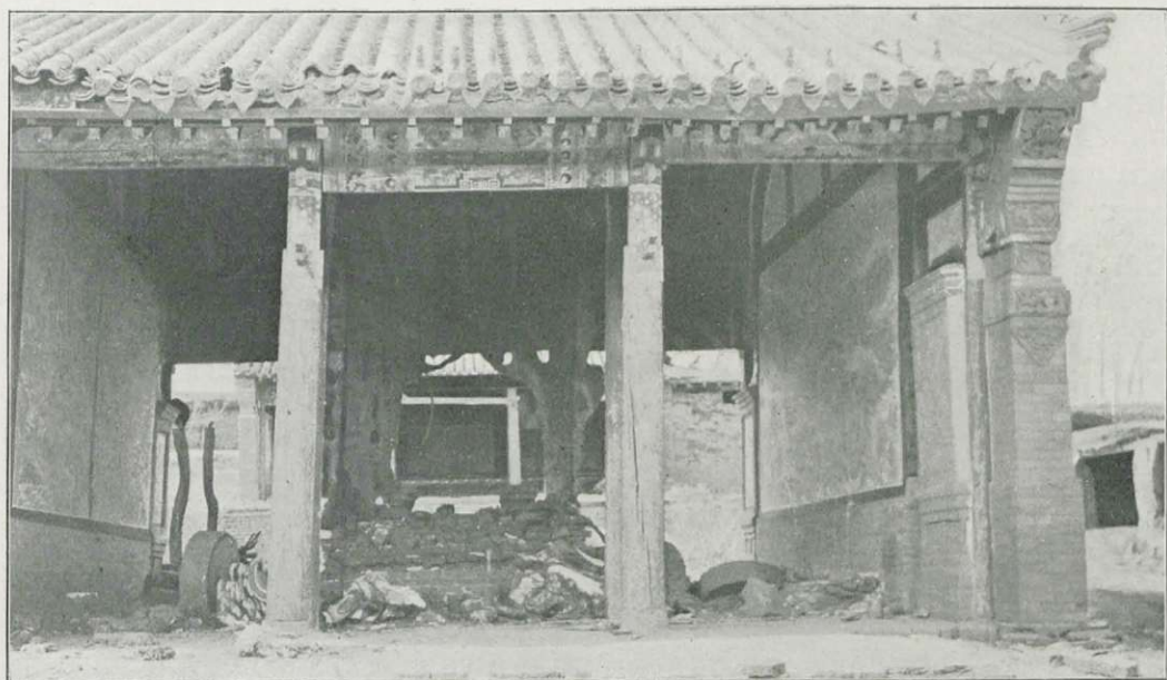
Разрушенная русскими кумирня около 85 го развѣзда.
