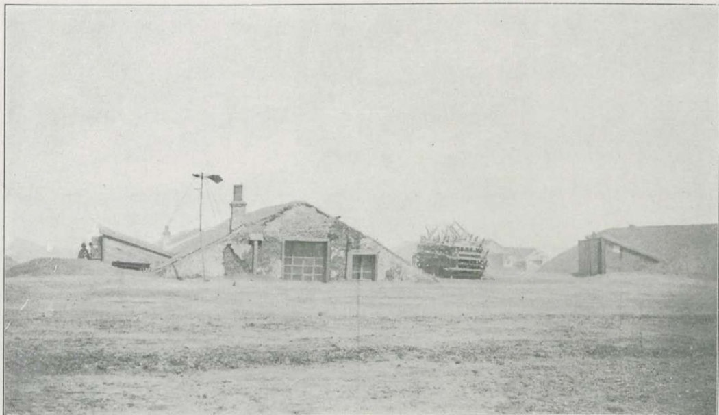
Гунчжунингъ. Землянка, занимавшаяся остро-заразными больными въ 45-омъ военно-полевомъ подвижномъ госпиталѣ.
