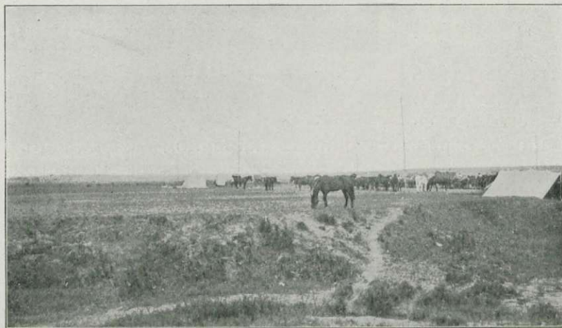
Годзяданъ. Станція безпроводнаго телеграфа.
