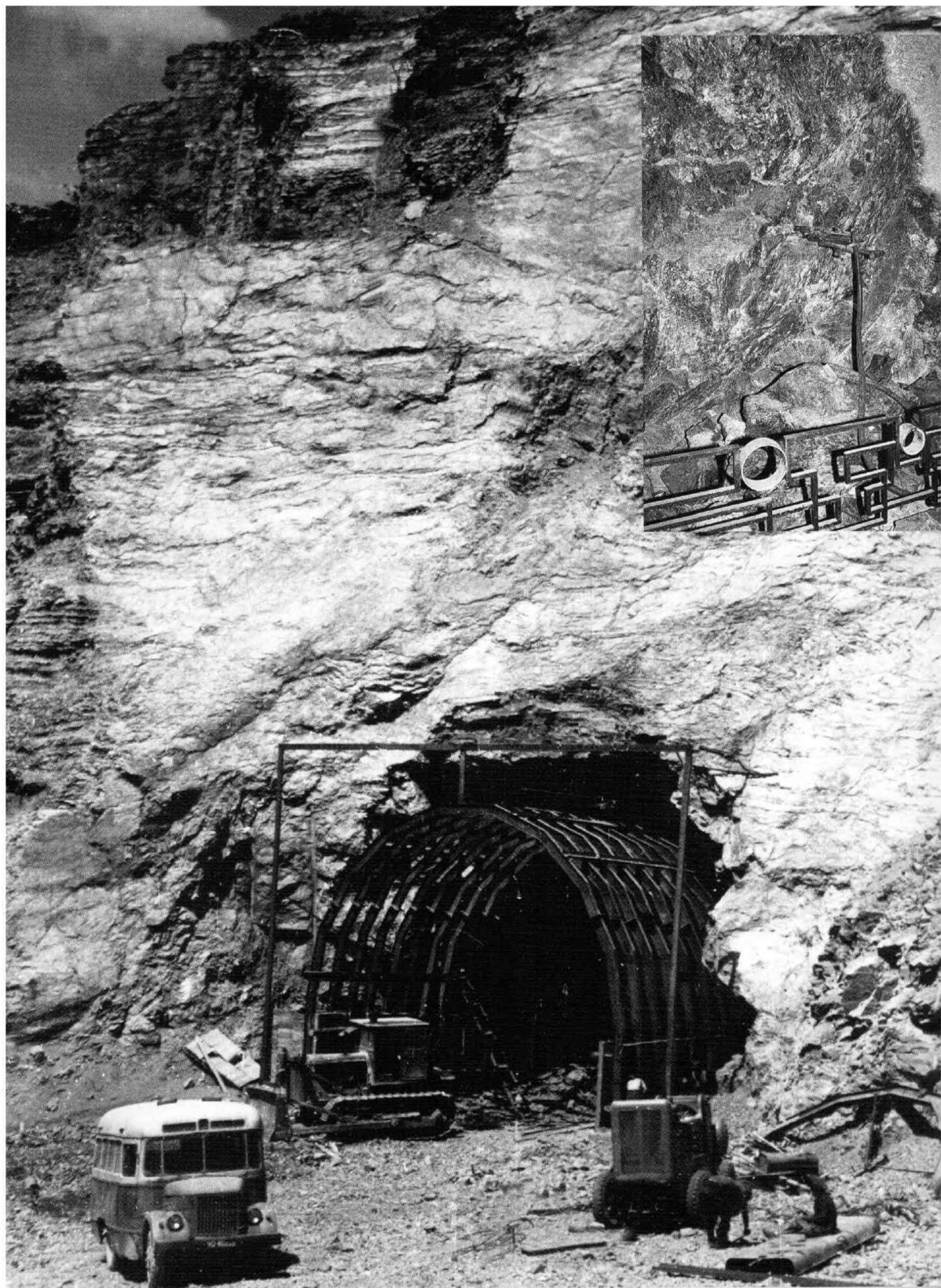
Начало строительства въезда на комбинат
