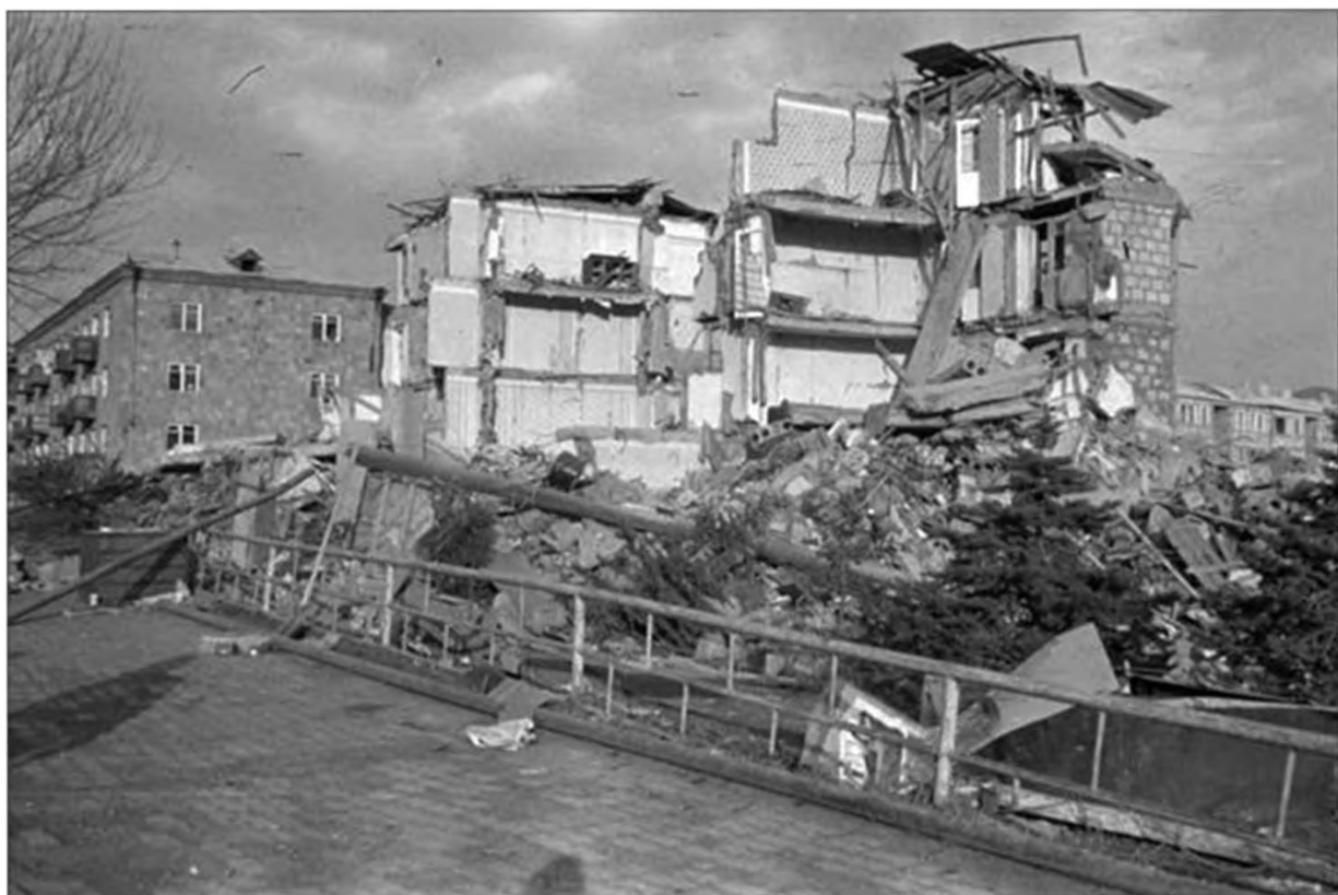
Землетрясение в Армении. Разрушенный город Спитак. 1988 г.
