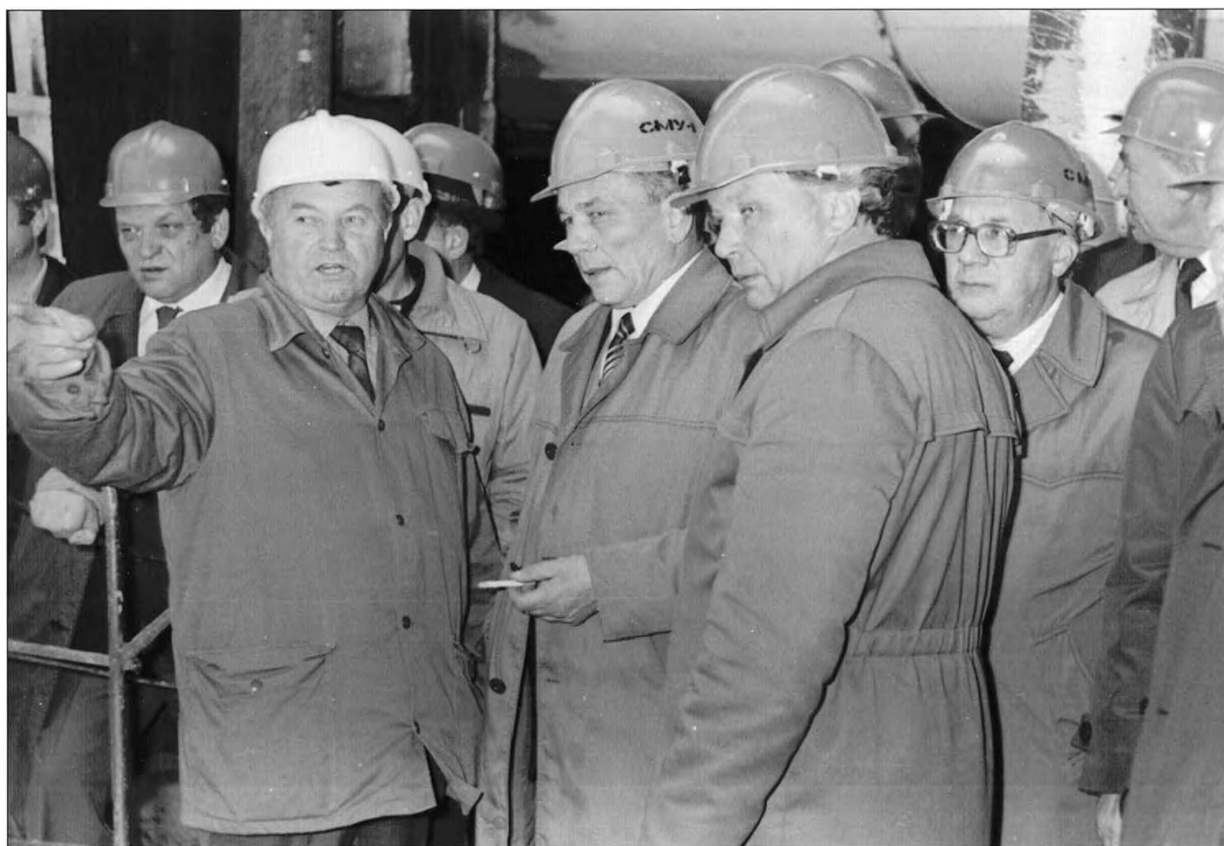
На строительстве ИАЭС. Слева направо: В.И. Рудаков, Н.Ф. Луконин, А.Н. Усанов, Ю.Ф. Жилин и другие. Снечкус, 1983 г.
