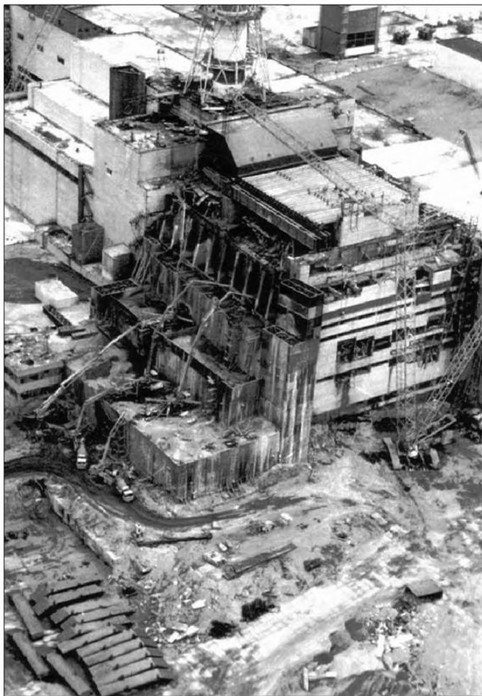
Состояние строящегося «Укрытия» перед установкой балки «Мамонт». Октябрь 1986 г.
