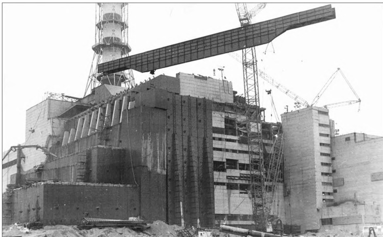
Подъем балки «Мамонт» на пределе грузоподъемности. 2 ноября 1986 г.
