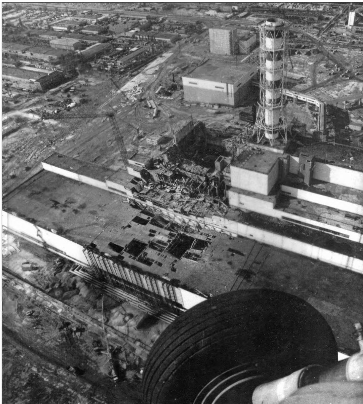
Разрушенный реактор 4-го энергоблока ЧАЭС. Фото с вертолета
