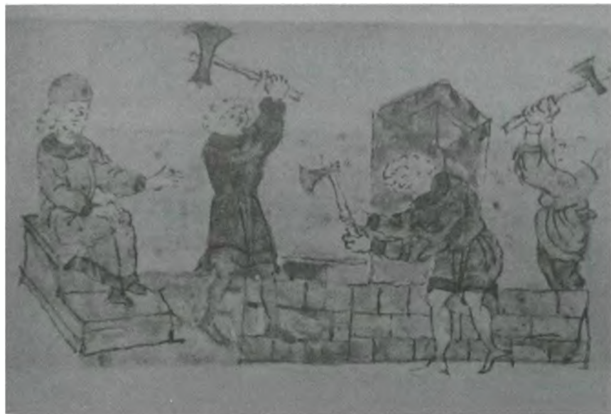
Строительство Успенского собора во Владимире.
