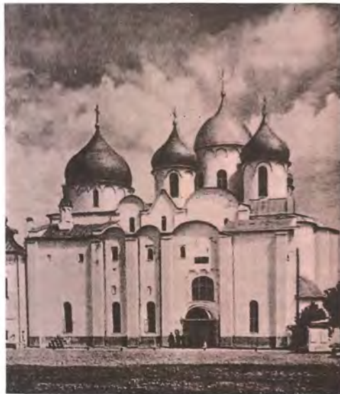
Софийский собор в Новгороде, сооружен в 1045—1050 гг. Фото Л. А. Матулевича.
