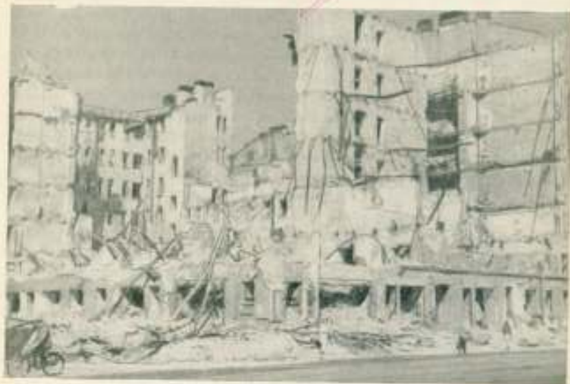
Разрушенный фугасной бомбой и сгоревший жилой дом на 5-й Краснодарской улице
