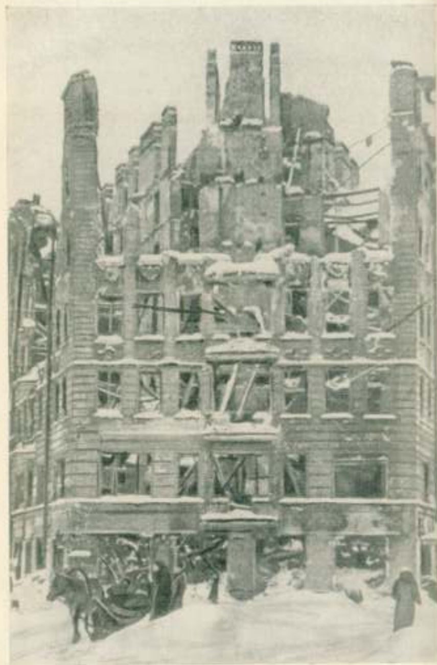
Сгоревший дом на Лиговской улице
