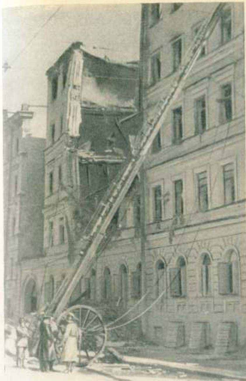
Пожар в разрушенном бомбой здании Исполкома Смольнинского районного Совета депутатов трудящихся
