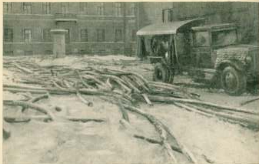
Пожарные рукава, замерзшие после пожара
