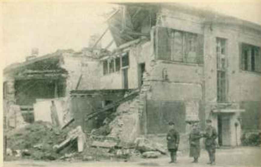
Разрушенное бомбами здание 70-й ВГПК
