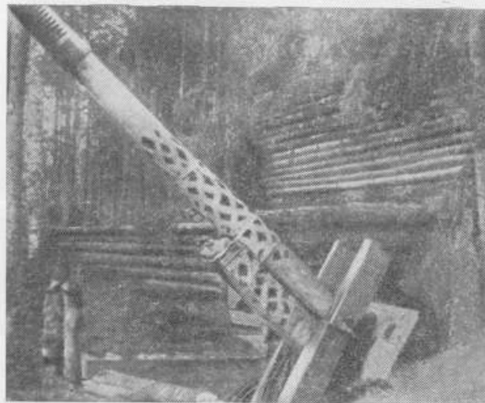
152-мм орудие в дзоте. Колонки предохраняются щитами от осколочного действия
