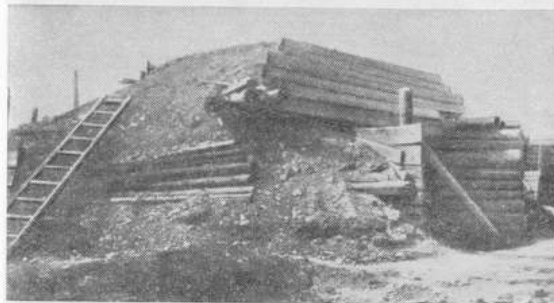
Мощный орудийный дзот 12-го гвардейского артиллерийского полка. Маскировка под дровяной склад, выдержал прямое попадание 150-мм снаряда
