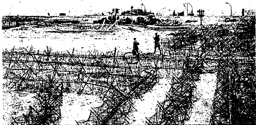
Рис. 16. Проволочные заграждения, прикрывающие окопы на молу.
