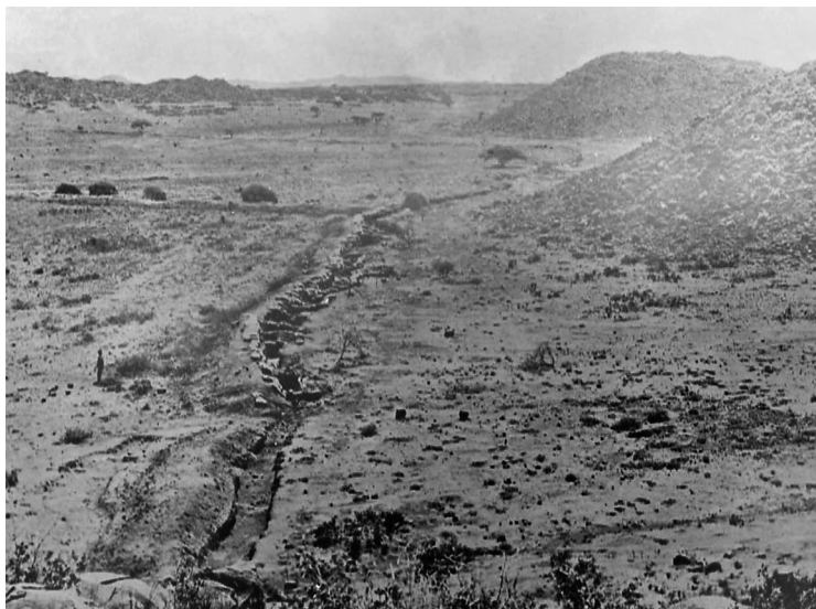
Траншеи буров у Магерсфонтейна
