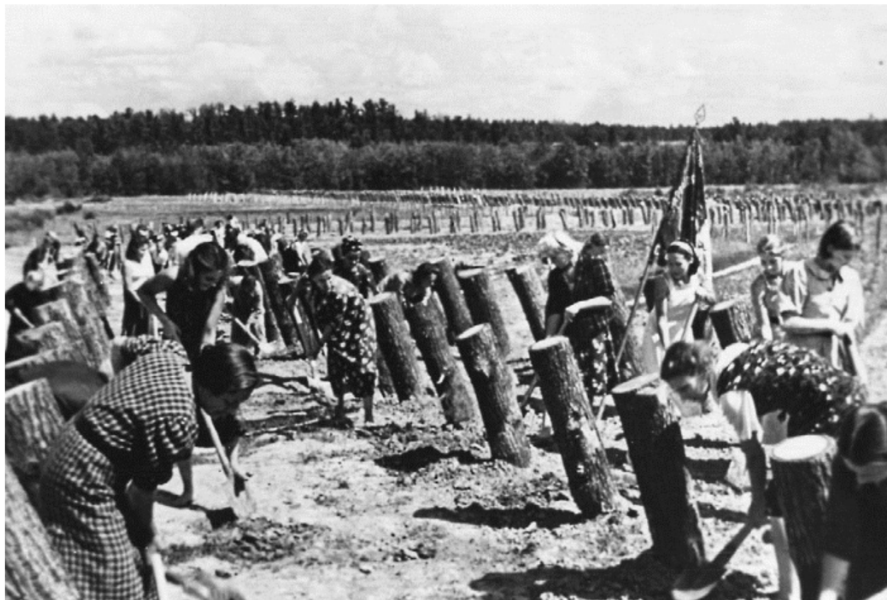
Строительство оборонительных сооружений. 1941 г.
