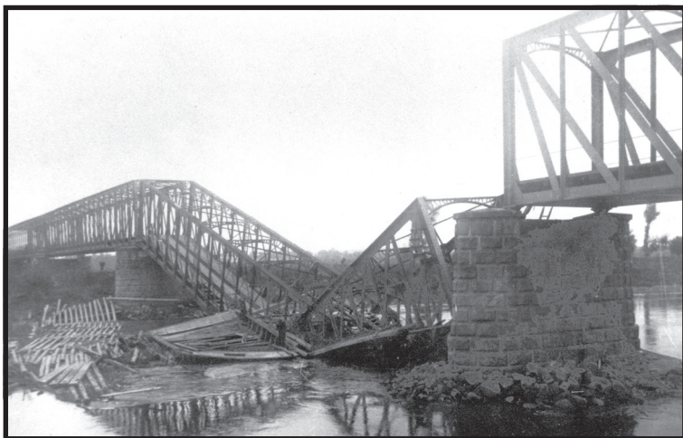
Разрушенный железнодорожный мост через реку Сап. 1914–1915 гг.
