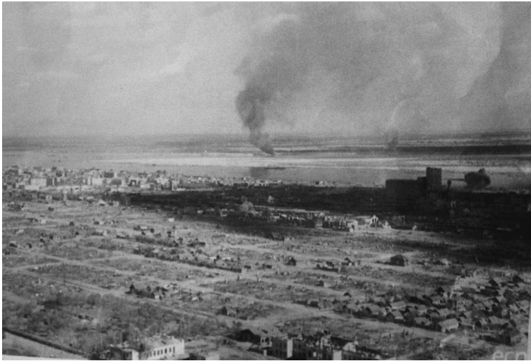
Вид на элеватор и расположенный севернее квартал многоквартирных домов на берегу Волги. На переднем плане частная застройка на Дар-горе. Осень 1942 г.
