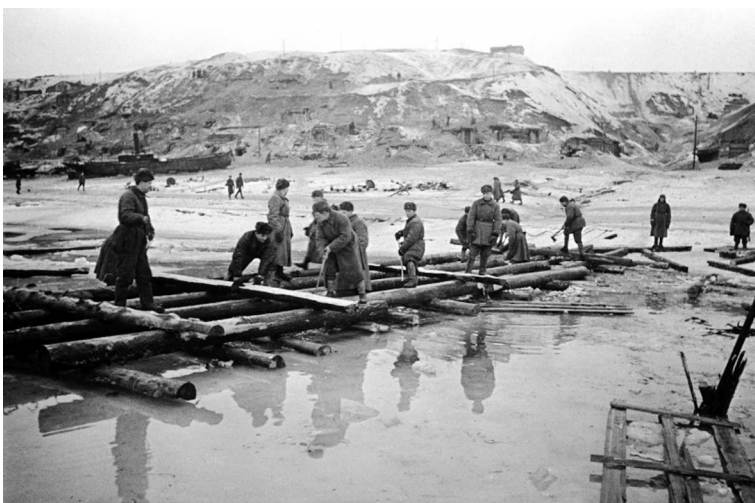
Военные саперы строят переправу через Волгу в Сталинграде. Осень 1942 г.
