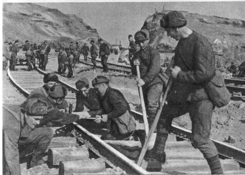
Строительство железной дороги. Центральный фронт
