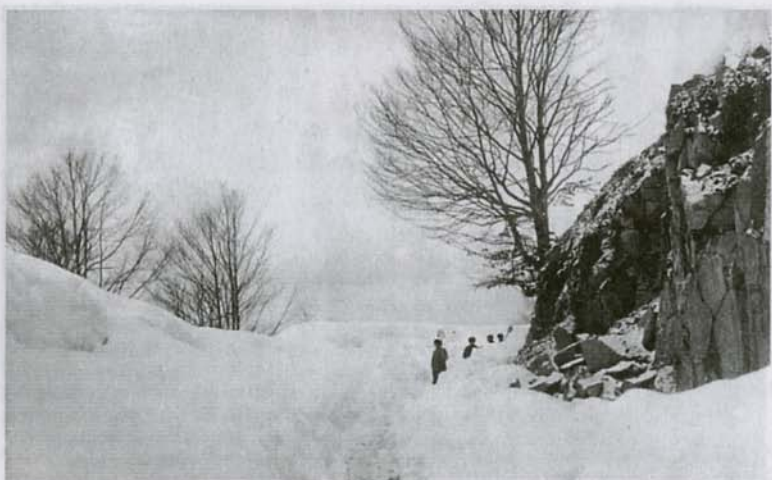
Кубанцы на строительстве шоссе Корбевац—Босильград, зима 1922/23 г.
