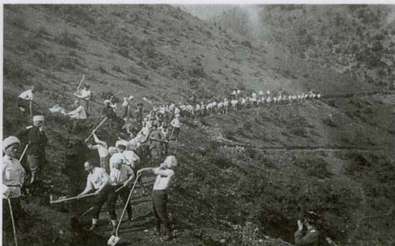
4-я сотня 2-го сводного Кубанского полка на постройке дороги
