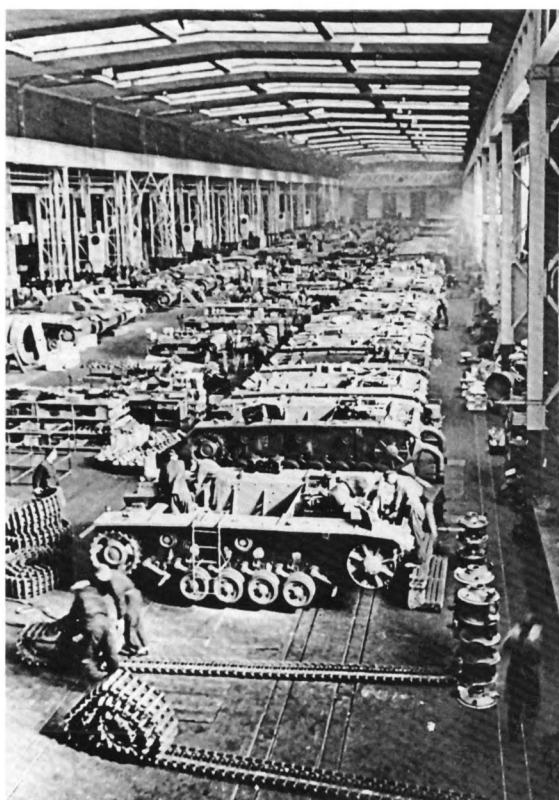
Цех по сборке немецких средних танков Т-III. РГАКФД
