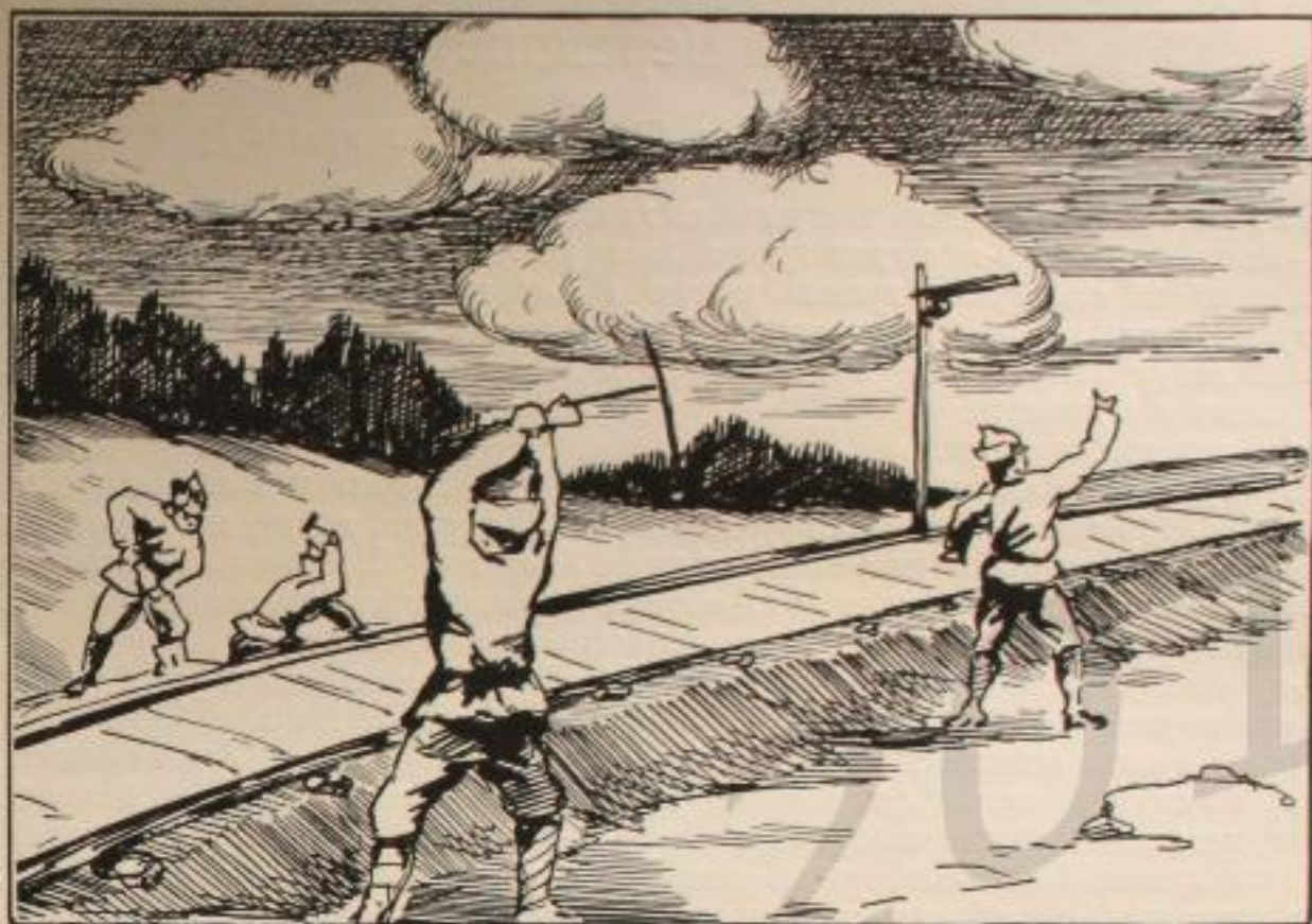
Красноармейцы 152-й бригады на ремонте железной дороги в Сибири.
