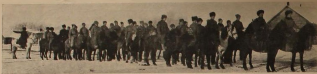
Челябинская батарея тов. Матюшкина в конном строю.
