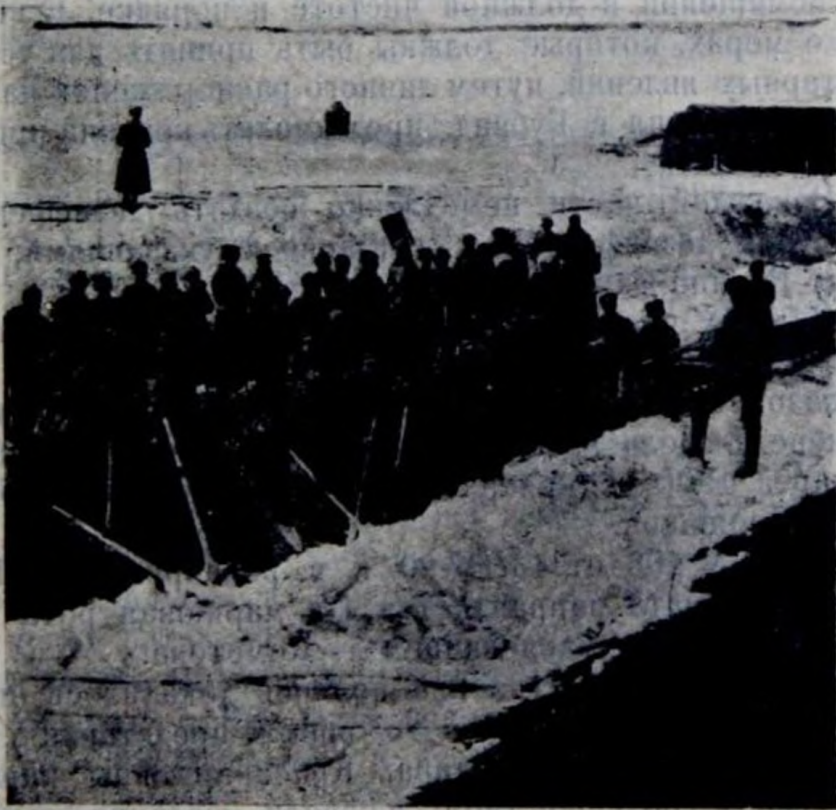
Караульный батальон на работах—очистка путей.
