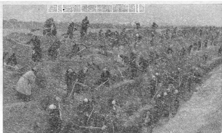
Рабочие «Трехгорки» на оборонительных работах. Москва, 1941 г.
