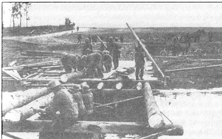
Немцы строят мост через р. Ижора
