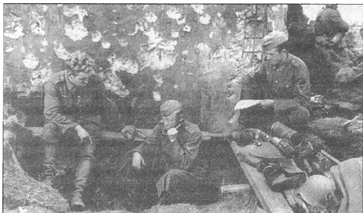
На командном пункте у разрушенного дота
