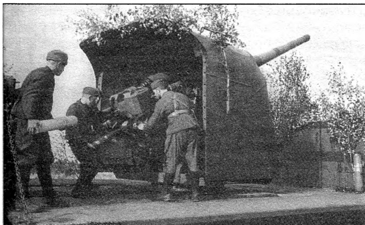
Железнодорожная артиллерийская установка с 130-мм орудием Б-13. Такие установки были построены на ленинградских заводах летом 1941 г. и принимали участие в сентябрьских боях
