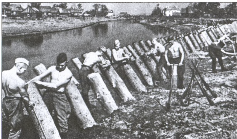
Сооружение противотанковых препятствий. Юго-Западный фронт, июнь 1942 года
