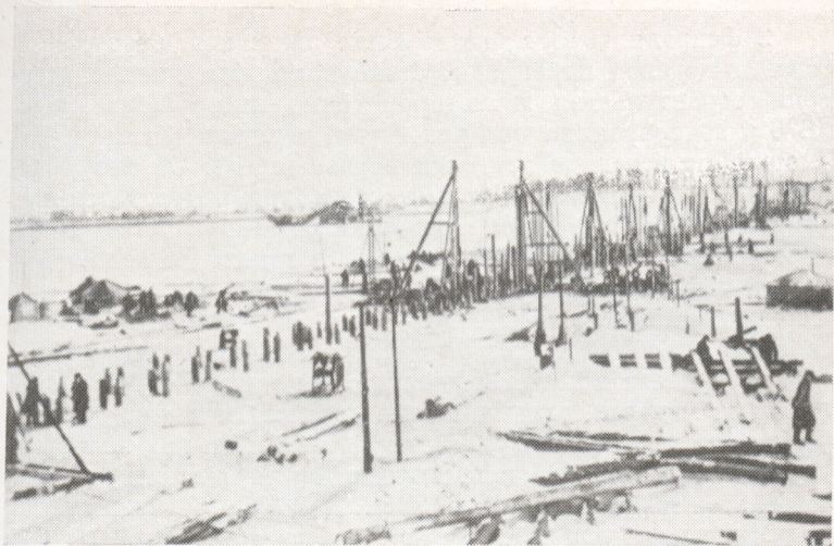
Строительство низководного свайно-ледового моста через р. Неву у Шлиссельбурга в январе 1943 г.
