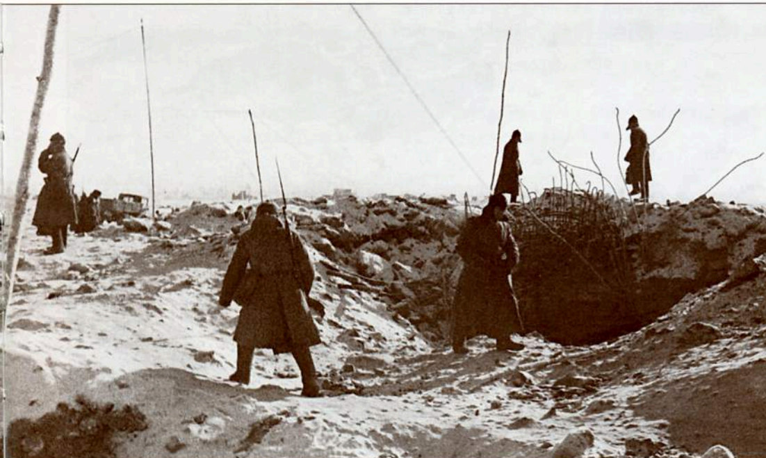
Подбитые Т-28 около ДОТ S4 «Поппиус» на высоте 65,5 после штурма. Справа виден подорванный каземат ДОТ (АСКМ)
