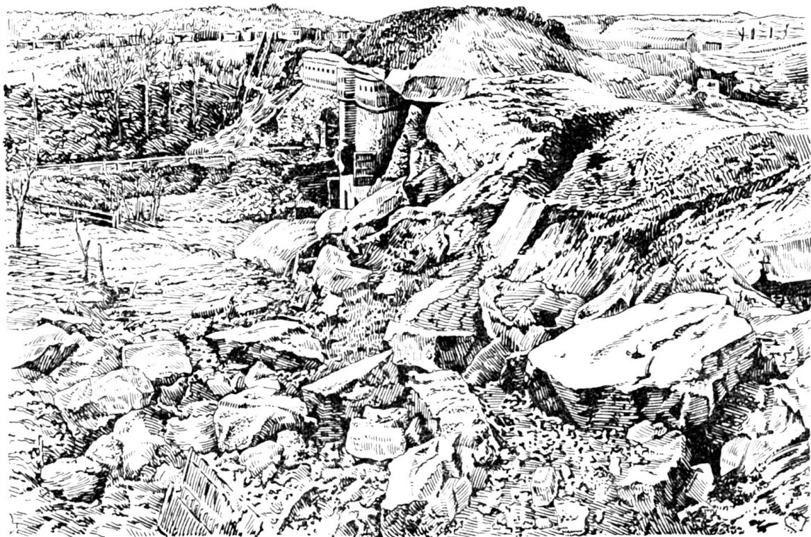
Черт. 20. Разрушение казармы № 46 при эвакуации крепости
