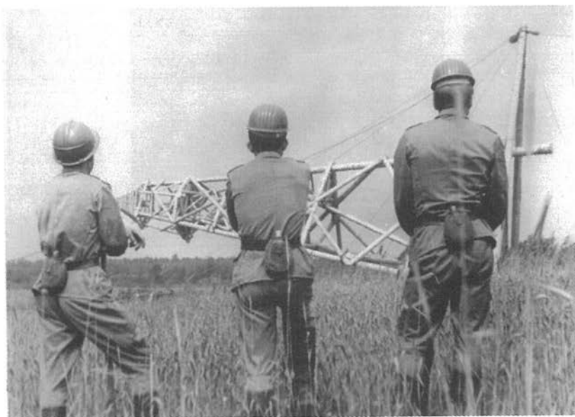
Подъем геодезического знака (сигнала) в 61-м топогеодезическом отряде. 1977 г.
