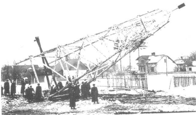
Подъем геодезического знака. 64-й топогеодезический отряд. 1950-е гг.
