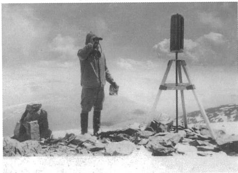
Геодезические работы в горах на высоте 3500 м. 1977 г.
