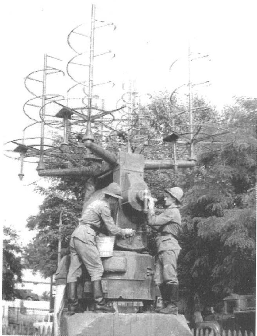
305-й АГП. Регламентное обслуживание антенного устройства. 1975 г.
