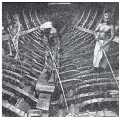
Промазывание днища противогнилостным составом — растительным маслом. Хорошо видна необычная конструкция судна
